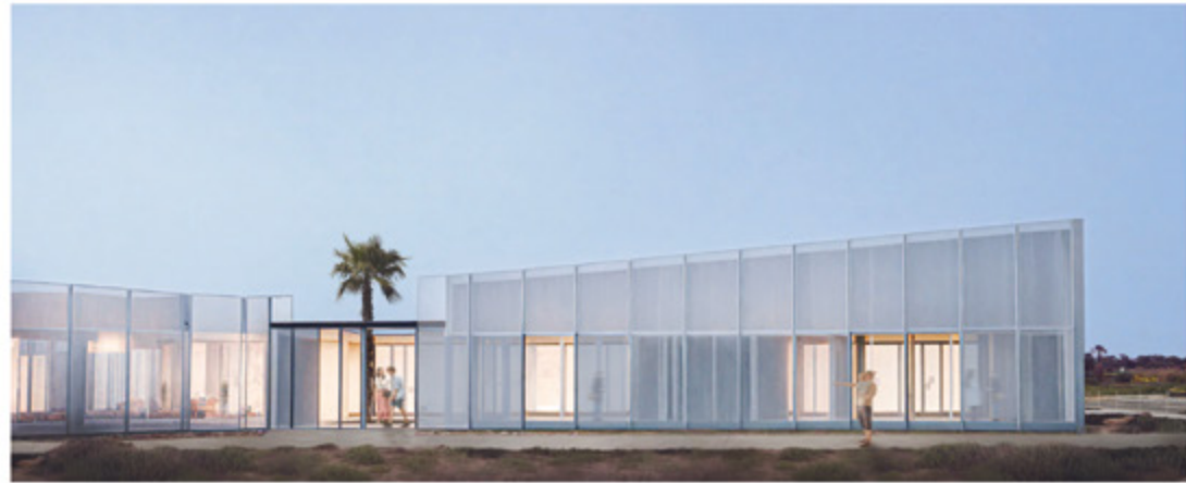
Widok na elewację zachodnią
